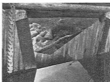
Kuva 29. Myllykorvenojan mittauspato (yläpuolelta katsottuna) ja vesiasteikko.
