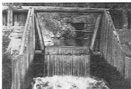
Kuva 28. Rajaojan mittauspato (alapuolelta katsottuna).
