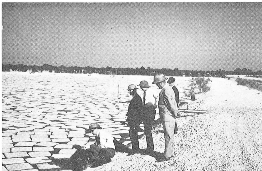
Kuva 12. Haihtumisen ehkäisemistä vesivarastosta kokeillaan Lounais-Afrikassa peitelevyjä käyttäen.
