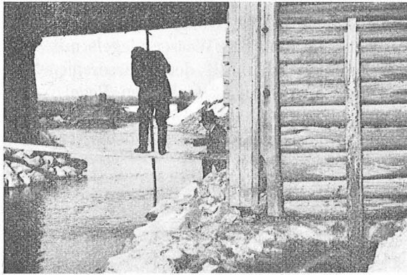
Fig. 3. Wassermengenmessung bei Pegel Nr. 25.
